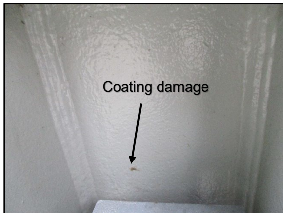
27. Anchor stud #7 paint chip
