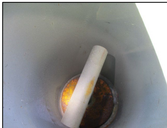
10. NE lid-stud pipe (inside) rust
