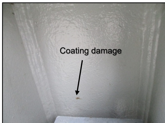
27. Anchor stud #7 paint chip
