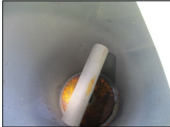
10. NE lid-stud pipe (inside) rust
