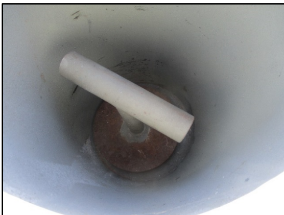
11. NW lid-stud pipe (inside) rust
