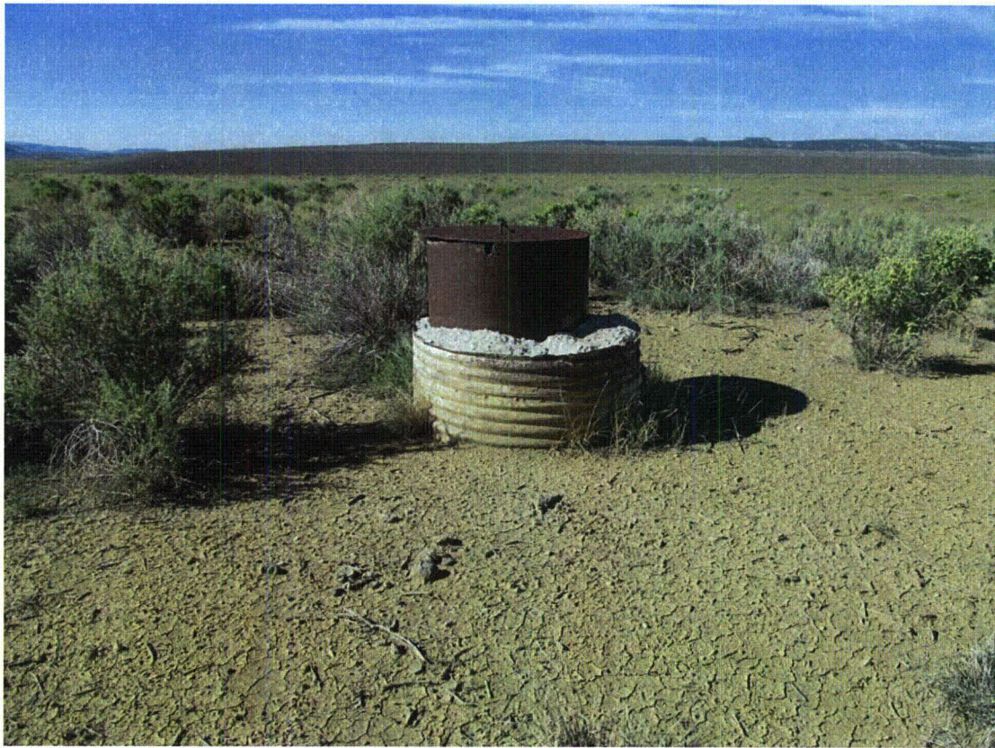
AMB 8/2013. PL-4. Secured mine vent shaft.
