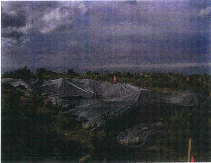
giant tarp over F1 units
