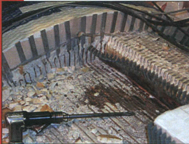
»SAMPLE N°1 »FINS CUTTING + RESIN DEBURING
