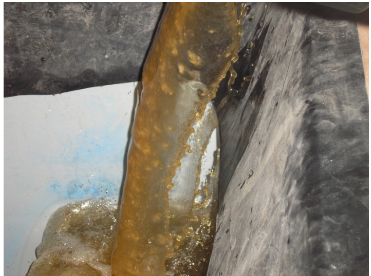
Photo 2-Debris Pour into Hopper
