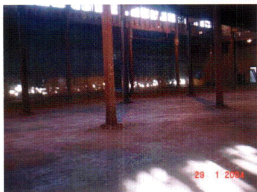
Photo 2-2. SU 2 (Building 503, Section 2)
