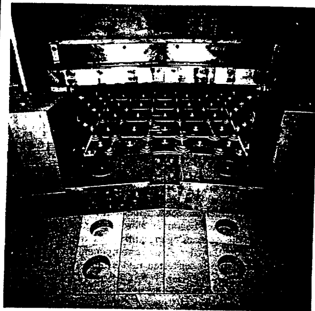
Abb. 8: Blick in einen Heißgaskanal, im Vordergrund Steine des Graphitaufbaues.
