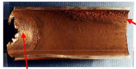
HRSG tube failure (EPRI, 2005)
